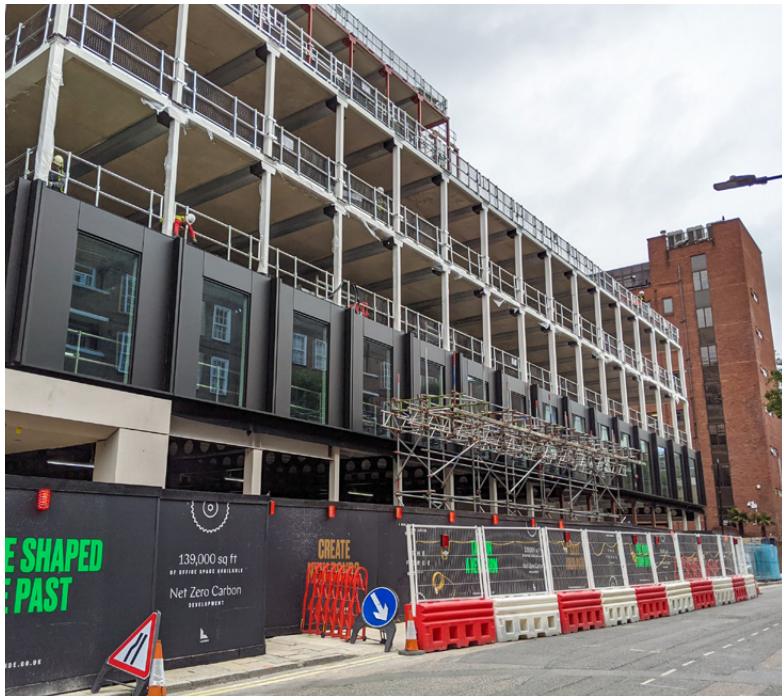
Il montaggio delle facciate
